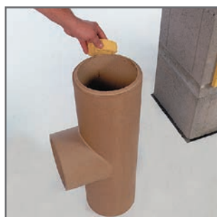
9.2 Megtisztítjuk a füstcső-csatlakozó csővégeit.
