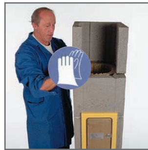
8.3- 8.4 A nyílással ellátott köpenytéglát felhelyezzük. A felesleges habarcsot lehúzzuk, a nyitott felfekvésű hézagokat teljesen eltömítjük. Meghajlítjuk és behelyezzük a szigetelő lapokat. Az előlő szellőztető csatornákat szabadon kell hagyni, ezért a hőszigetelő lapot le kell vágni.
