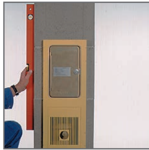
7.2 A kéménytalpat függőlegesen a habarcsba állítjuk.
