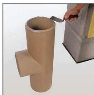
9.3 Hézagkittet hordunk fel a csatlakozó idom alsó peremére.
