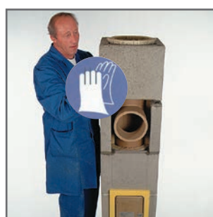
9.7 Az így előre előkészített köpenytégglát felhelyezzük.
