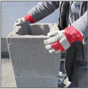
6.1 A köpenytéglát a habarcs-terítésbe helyezzük
