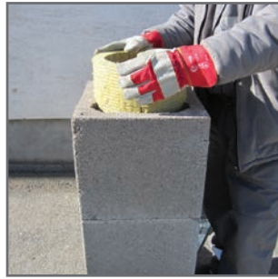
6.2 A szigetelő lapot meghajlítjuk és behelyezzük.
